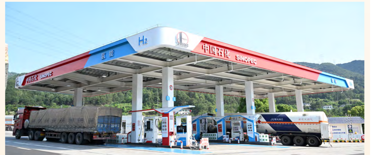
重庆公司“氢油气电”综合补能站
