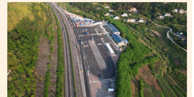
重庆公司黔渝高速赶水停车区俯拍图
