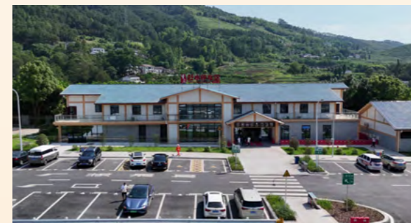
重庆公司黔渝高速赶水停车区正视图
