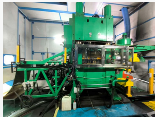
8 号老 D7 蒸冲置换为 D7 蒸新线
