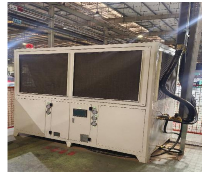
公司制造厂投用空气能模温机组替换传统机型，实现电耗节约
