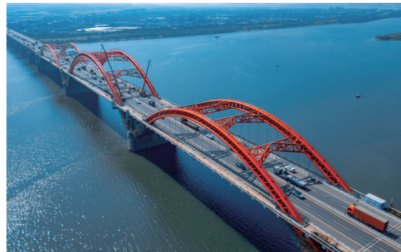
① 湘江黑石铺特大桥
