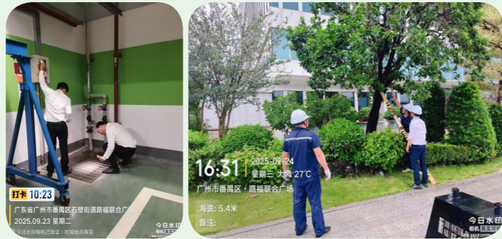
广州路福项目防台防汛现场照片
