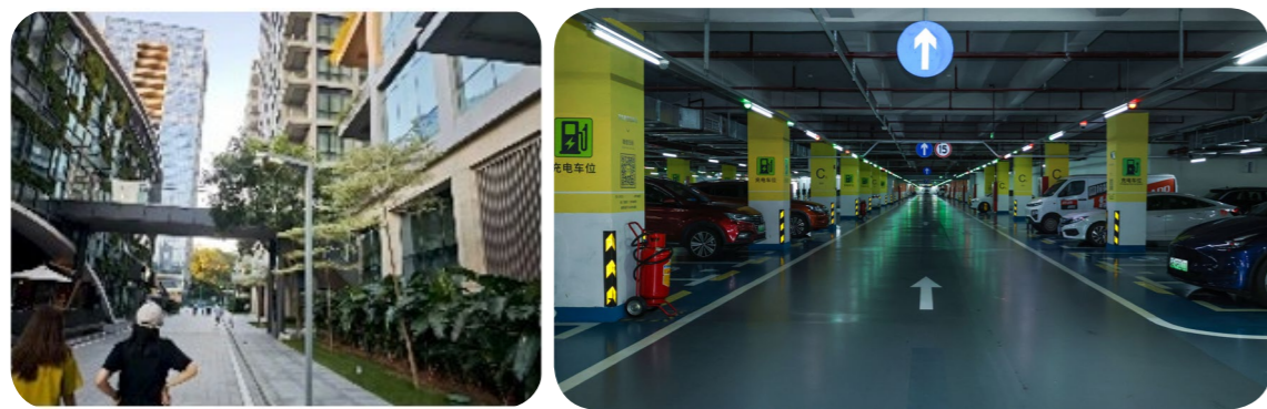
侨城坊园区路灯增设光感控制、停车场更换节能灯管
