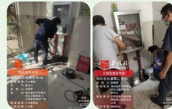
武汉 38 街小区隐蔽漏水点维修现场
