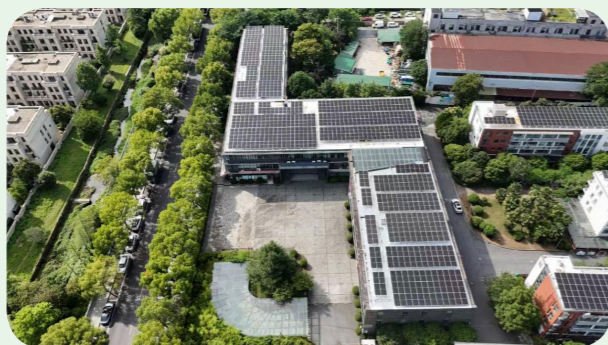
杭州昆仑工坊项目光伏应用照片
