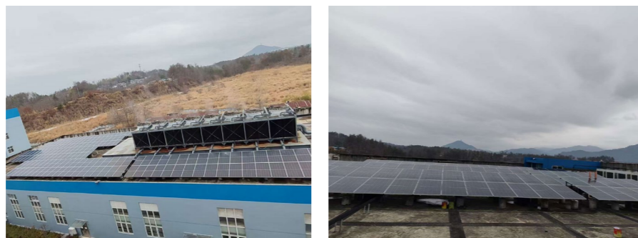
屋顶安装光伏
