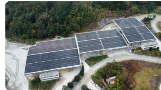
6 屋顶光伏铺设
