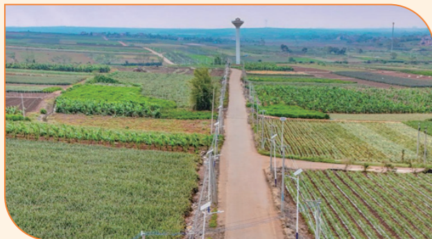
▲ 京基智农乡村道路亮化工程
