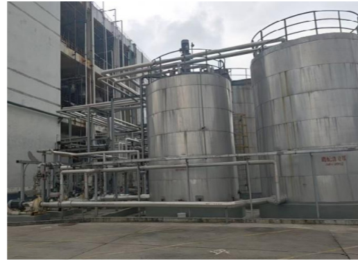
鼎盛锂业推进节能技改项目
