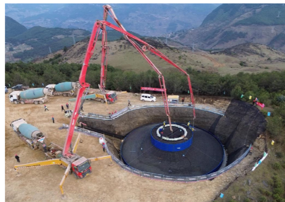
42.08 万千瓦在建风电项目
