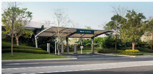
充電網絡建設工程
