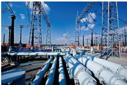
▲ 国内首套1100kV GIS产品应用于我国首条特高压示范工程—晋东南站
