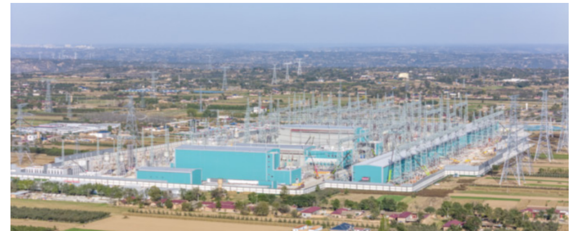
陇东 - 山东 ±800 千伏特高压直流工程
