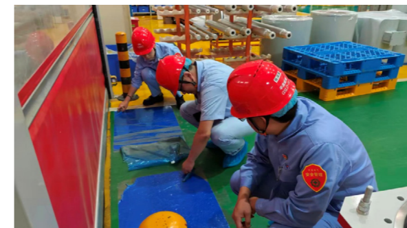
平高威海车间现场质量巡视
