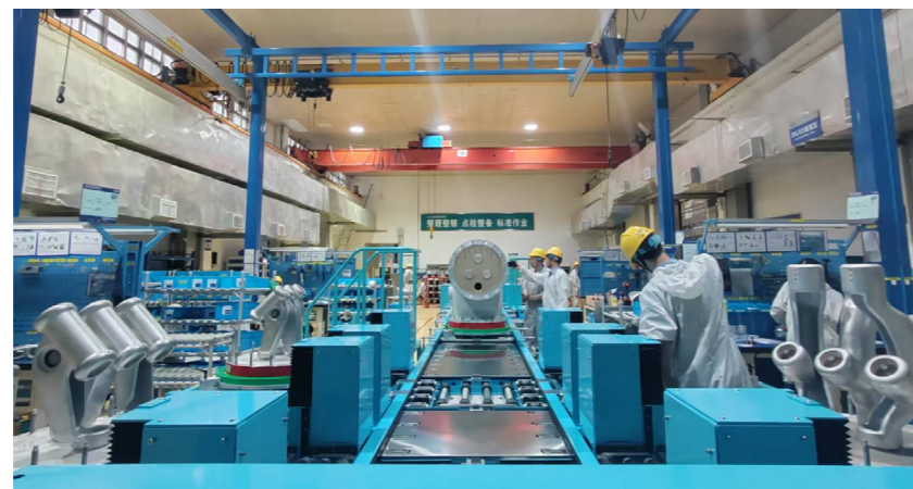
三工位自动化装配线
