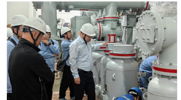
平芝公司现场安装质量检查
