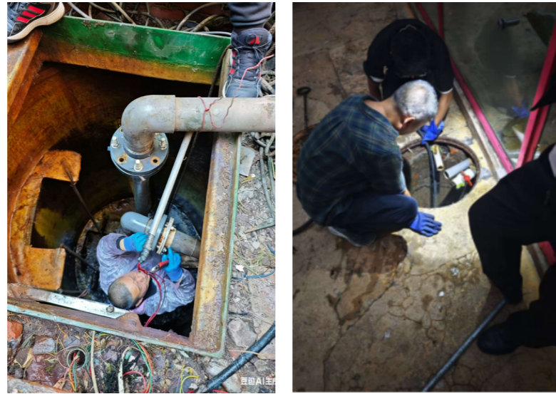
工程部开展园区化粪池专项改造与运行监测
