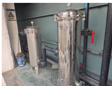
▲ Effluent Reuse Project
