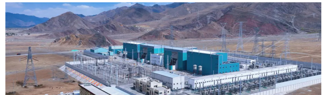
助力青藏直流二期扩建工程正式投运
