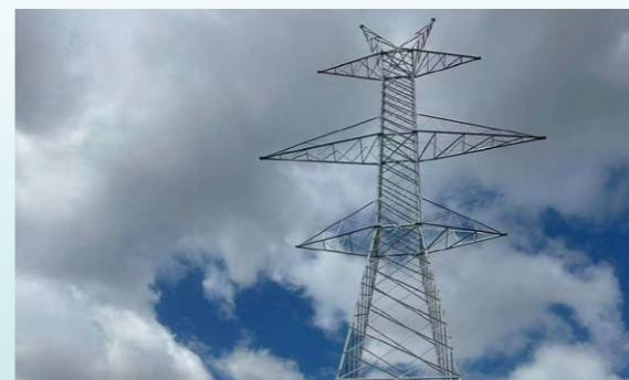
希腊400kV架空输电线路铁塔供货项目
