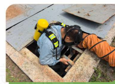
演练进入有限空间开展作业
