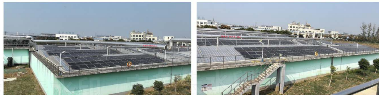
宿州经开区污水处理厂铺设太阳能板
