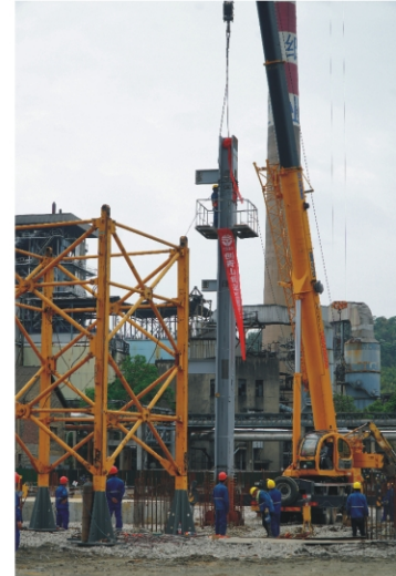
◆碱回收技改项目碱炉立柱
