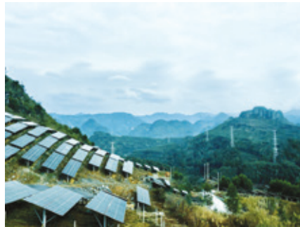
亞信興源與四川省探索新能源場站建設
