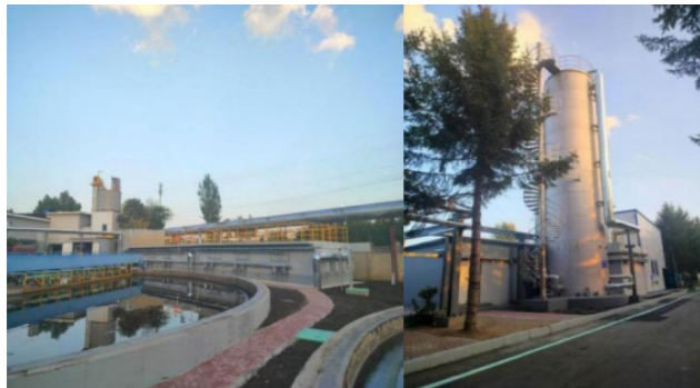
污水处理设施及三级水处理设备
