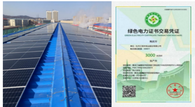
屋顶光伏+绿电证书
