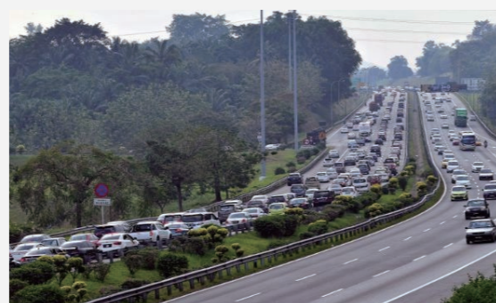
PLUS高速公路扩建工程
