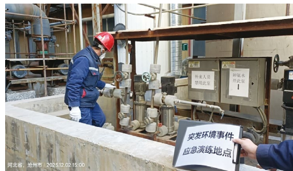
燕京玻璃瓶厂开展氨水泄漏应急演练
