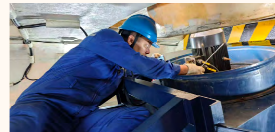
广东新能源在场站设立现场指挥部，实行靠前指挥，顺利抗击强台风“麦德姆”。台风过后，快速开展设备二次检查与系统调试，及时恢复发电功率，保障设备高效运行，为区域能源安全注入绿色动能。
