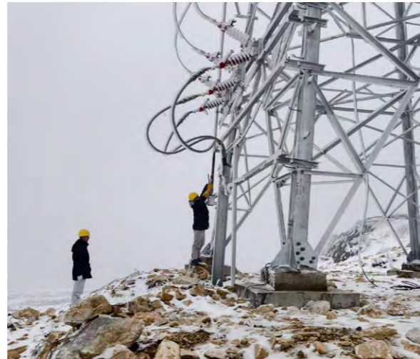
甘肃新能源运检人员检查终端塔隔离接地刀闸操作机构
