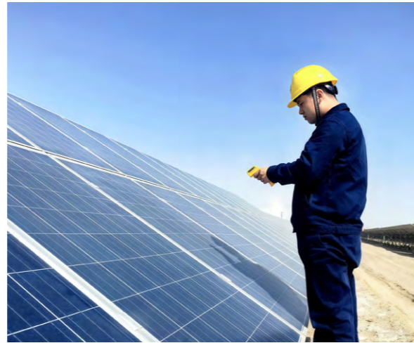
青海新能源运维人员进行光伏板红外测温工作
