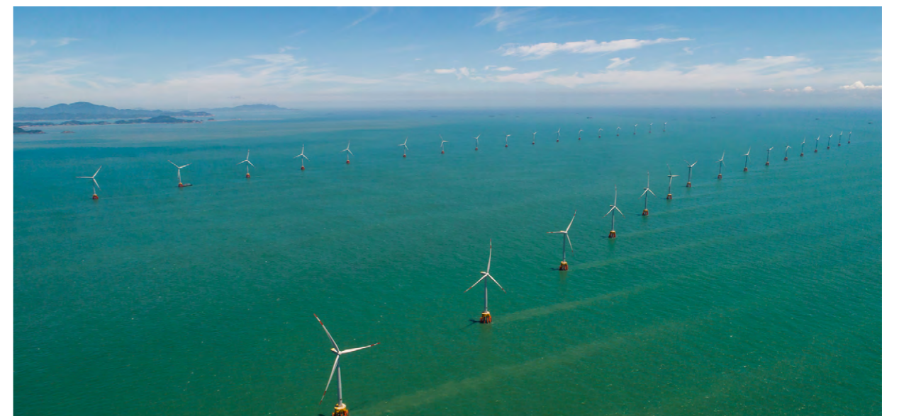
2025 年 12 月，舟山海上风电国电象山 1 号海上风电场（二期）工程荣获电力建设工程绿色建造评价三星工程
