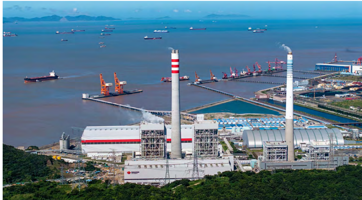
2025 年 5 月至 6 月，舟山 500 千伏线路双停孤网期间，国能浙江舟山发电公司全力保供稳发，护航海岛民生与旅游旺季用电，获国网舟山供电公司锦旗致谢
