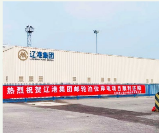
辽港集团邮轮泊位岸电项目现场
