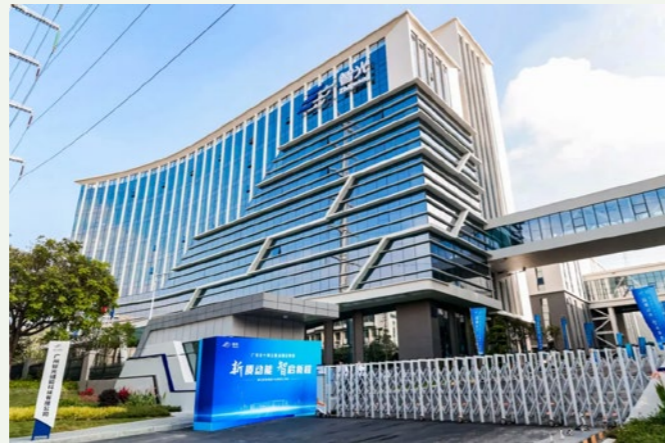
智光新型储能产业园
