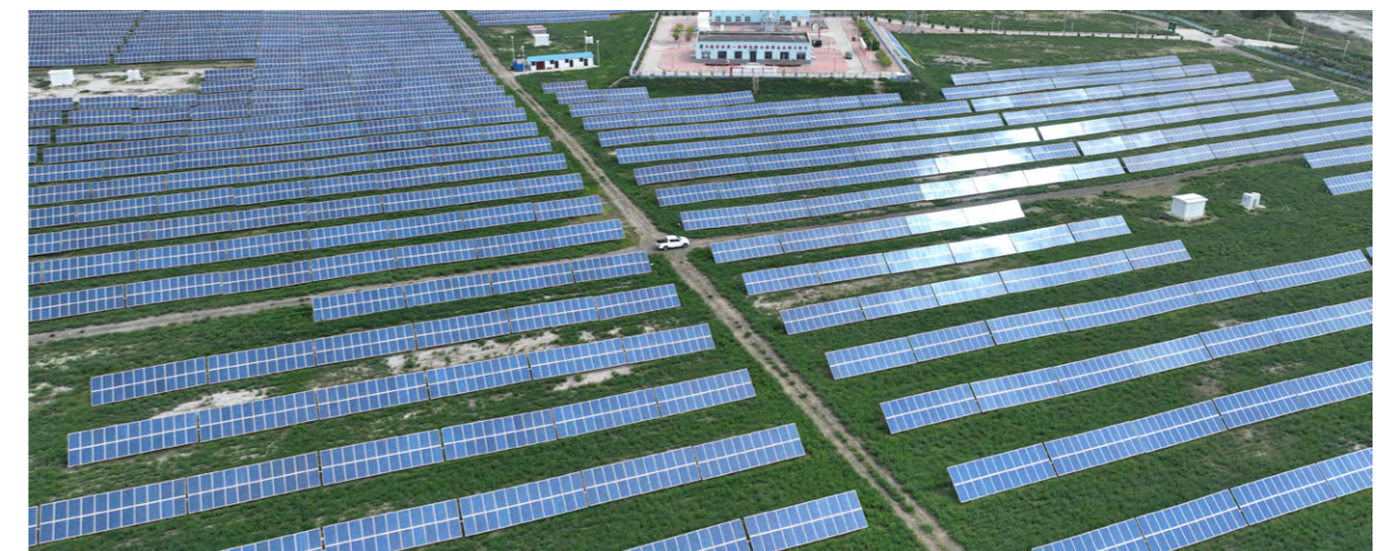
露天煤矿排土场光伏项目
