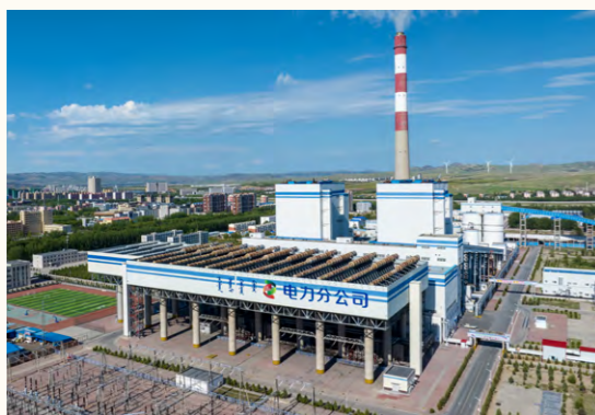
为了保障国庆、中秋期间居民采暖质量，电力分公司提前 6 天开栓，确保“双节”假期供热达到最佳水平
