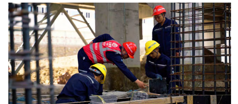
项目现场检查
