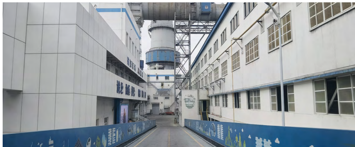
霍煤鸿骏铝电公司煤电铝烟气污染物超低排放示范项目，配合高效的烟气净化系统，污染物控制更严格，氟化物排放量能低至国家标准的五分之一
