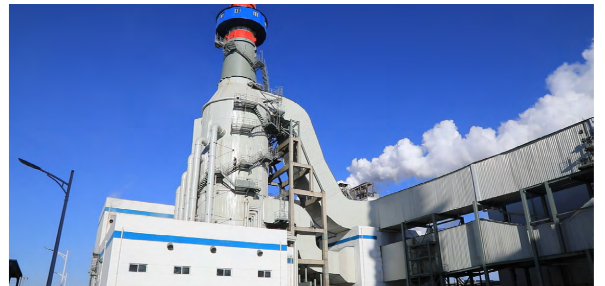
电力分公司火电机组
