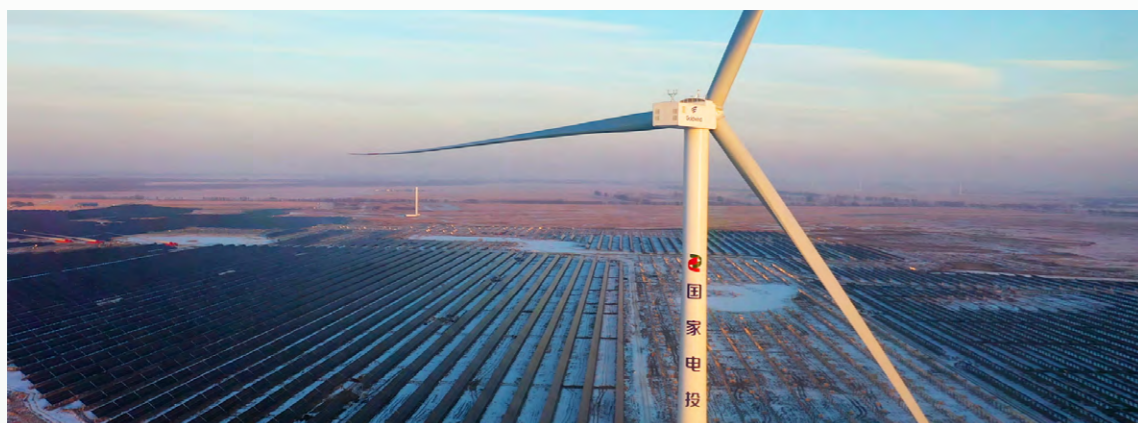
防沙治沙和风电光伏一体化项目
