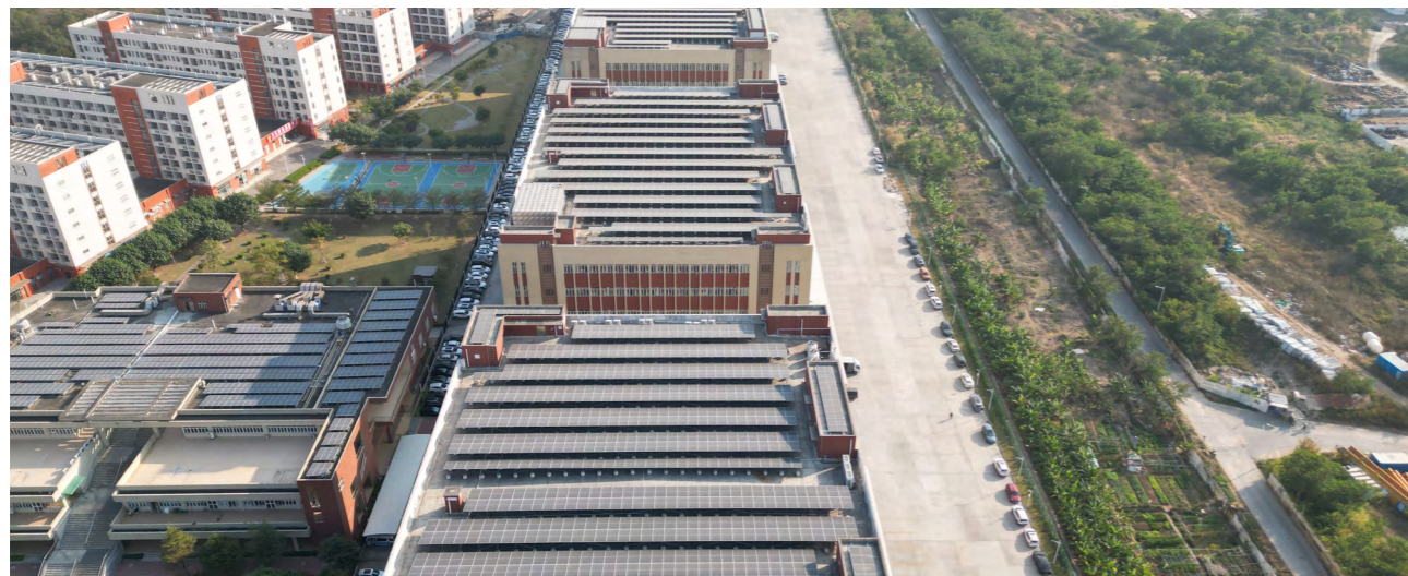
南屏园区光伏发电鸟瞰图
