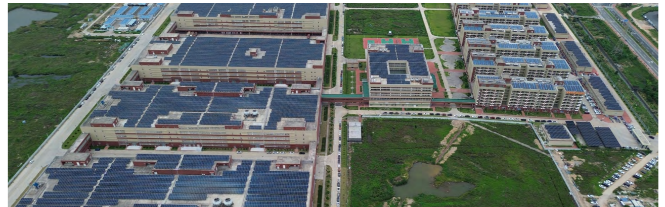
平沙园区光伏发电鸟瞰图
