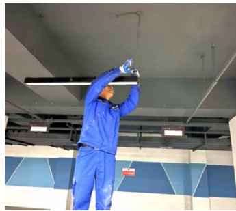
车库照明灯具更换
