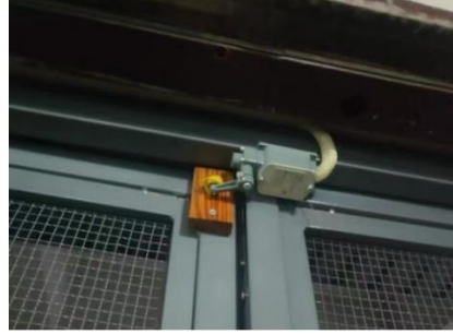
设备房灯具自动控制器
