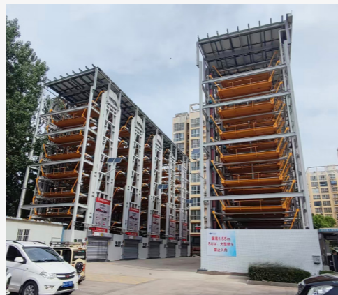
>>> 多氟多建设智能立体停车库
