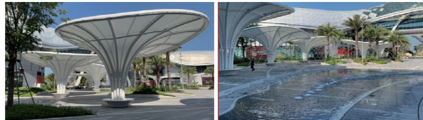
△ 室外廣場淺色鋪裝及遮陽構築物 (三亞國際免稅城 C 區照片)
