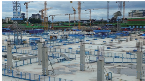
△ 三亞國際免稅城三期商業項目採用「預制結構柱 + 疊合板」
