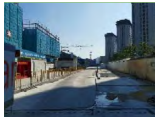
施工车辆冲洗设备通道
