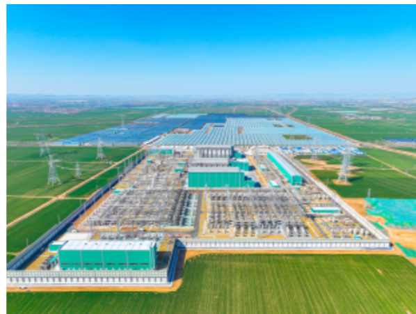
“陇电入鲁”特高压直流工程
