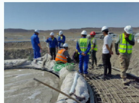
工程项目质量竞赛现场
