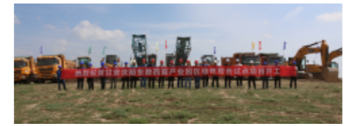
甘肃庆阳“东数西算”产业园区绿电聚合试点项目
