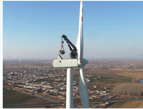
UTC600 自主爬升吊機工作現場
