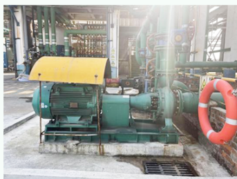
整流冷却水回收改造
