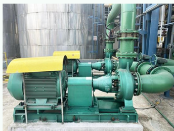
片碱机冷却水回收改造
