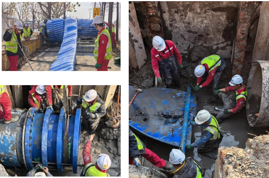
DN1200 供水管道内衬修复案例
