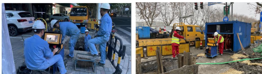
管道检测工程案例
