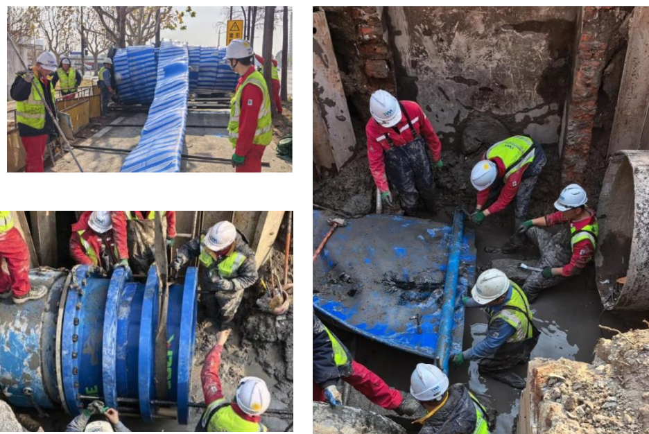
图 14 DN1200 供水管道内衬修复案例
