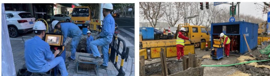
图 13 管道检测工程案例
