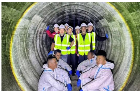
图 17 某地管道非开挖修复项目
