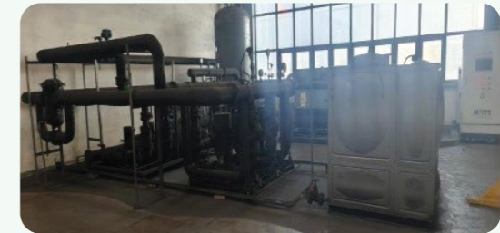
熔炼冷却水余热热泵采暖系统
