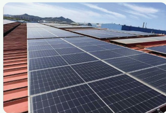
厂房顶分布式光伏电站
