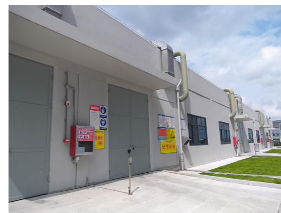
危险废物仓库
