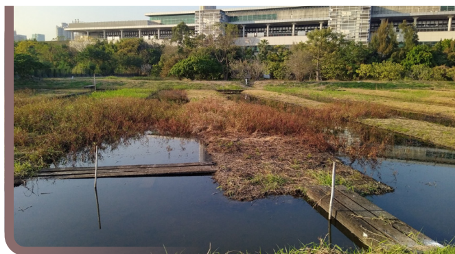
利用報廢枕木建造生態監測徑，支持生境監察工作
