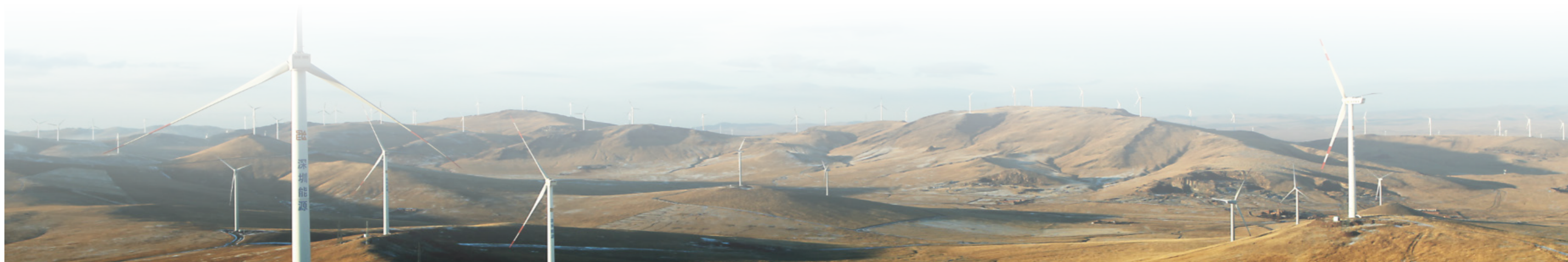
内蒙古满洲里风电项目
