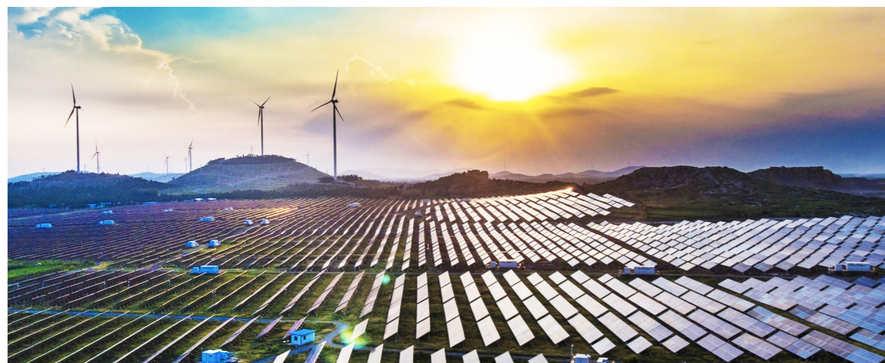
邳州燕子埠风电光伏项目
