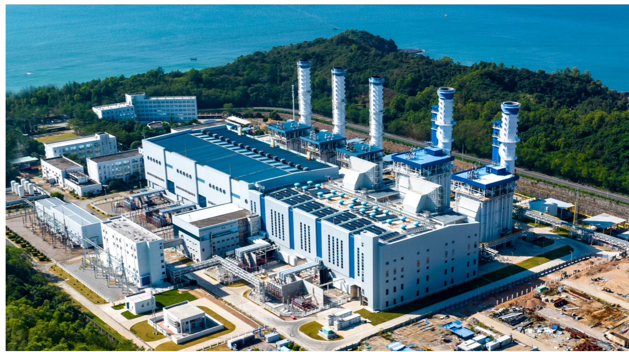
东部燃气电厂
