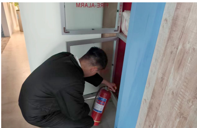
办公区域消防安全检查
