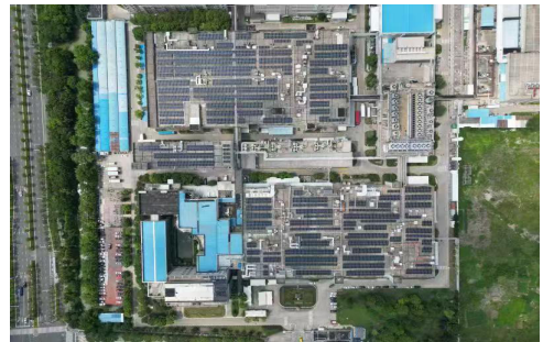
通富崇川工厂光伏项目
