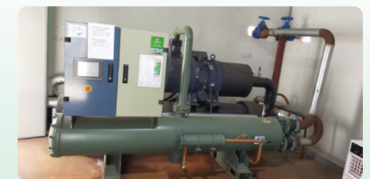
瑞欣装材冷却水循环使用系统
