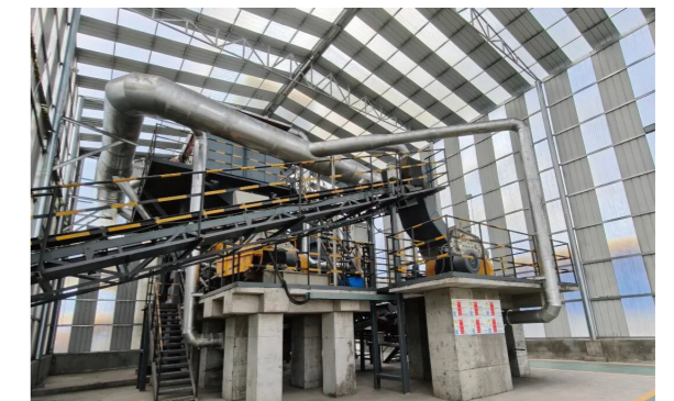
Coal Gangue Backfill EPC Project Site
