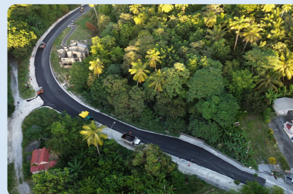
巴巴多斯苏格兰地区道路修复项目
