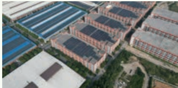
高明分公司生产基地厂房屋顶光伏
