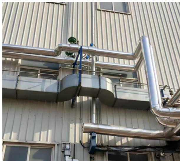
威远药业—制剂主蒸汽管改造
