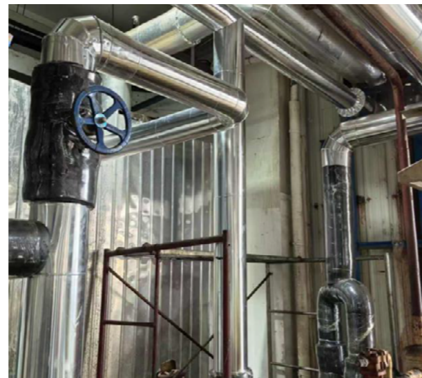
威远药业—制冷站冰机改造
