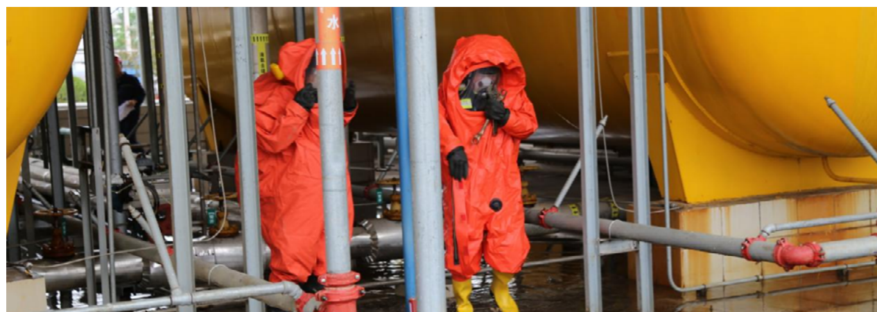
威远生化—液氨储罐根部阀门泄漏应急演练
