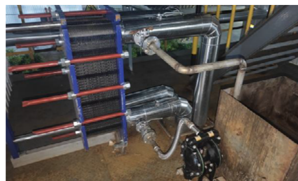
双吉化工—MVR 安装板式换热器
