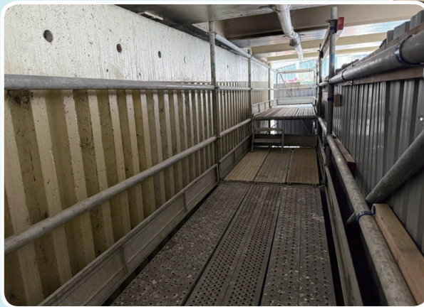
Description: Bearing replacement work at Fo Tan Footbridge 描述：火炭行人天橋軸承更換工程
