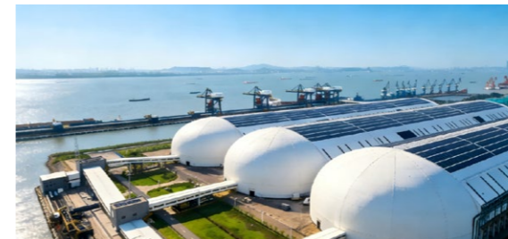
江蘇靖江港園區分佈式光伏
