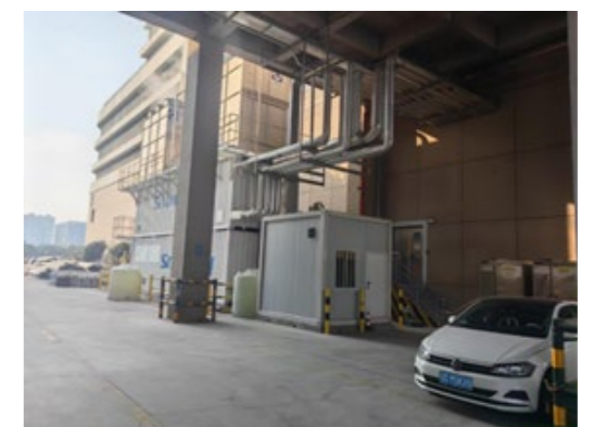
製冷機組集約化
