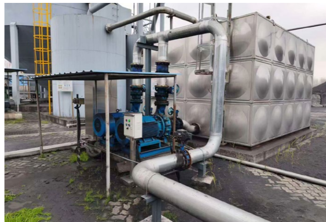
南京西壩堆場三角地蓄水池改造
