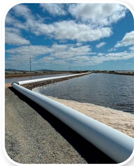
● Cheetham 在Port Alma 建造了新的導流槽，以保障公司營運免受日益加劇的河道侵蝕的影響。
