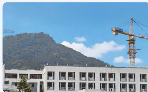
新教學樓施工現場
