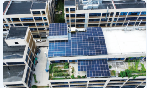
分佈式光伏電站
