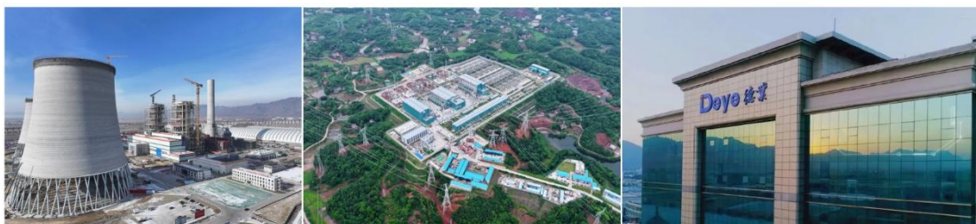
中国能源建设集团内蒙农灌机电 井地下水资源节约集约利用项目
